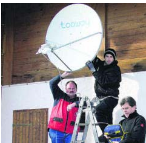
Dagobert Ebner (links), Horst Faschian (rechts) und Valentin Hofmann montieren einen Empfänger in Außer-Urberg.
